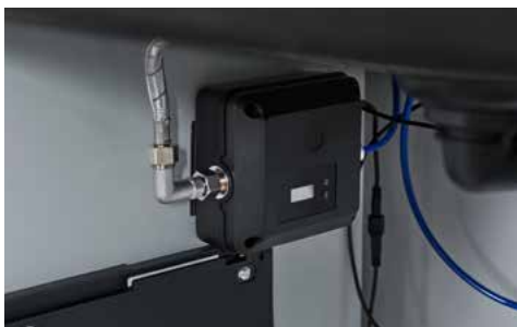
Platzsparend und übersichtlich: Die Steuereinheit zeigt auch die Restkapazität des Filters.
